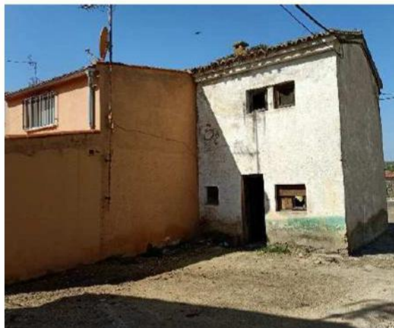
Vista de las fachadas de acceso y trasera al solar anexo.
